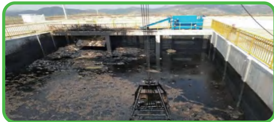
原油储油罐底泥
